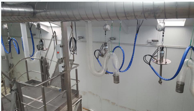
Acceso parte superior de la cisterna: estructura, cabezales de lavado y tubos de secado
